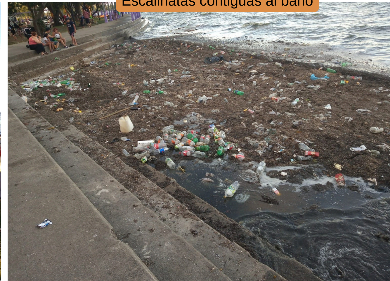
Escalinatas contiguas al baño
